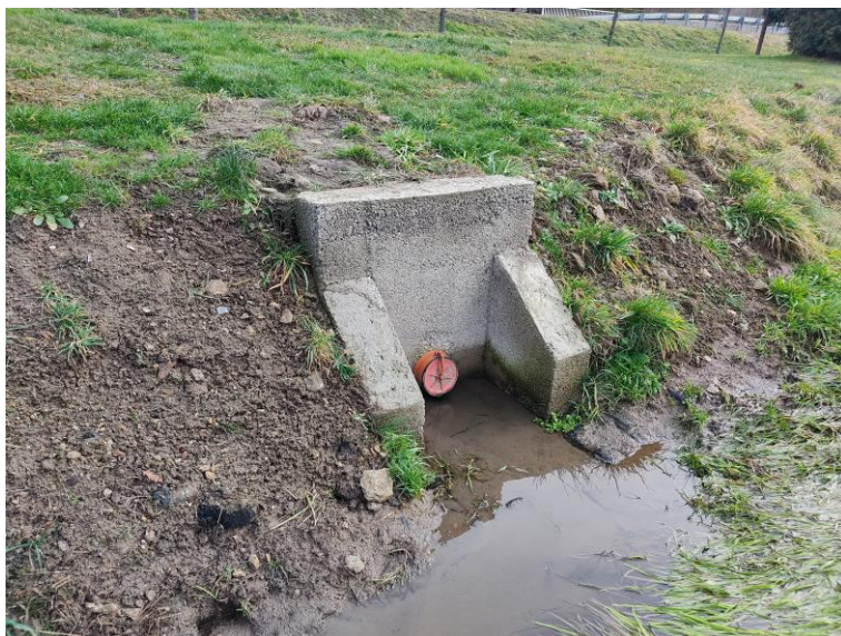
Obr.: Výtokový objekt z domovní ČOV
