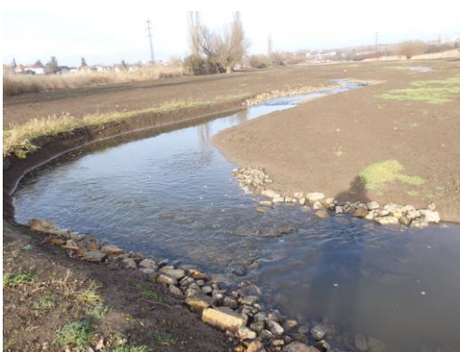
Obr. Doplnění přechodových úseků formou kamenného zához zatlačovaného do dna – nastavení hladiny v toku
