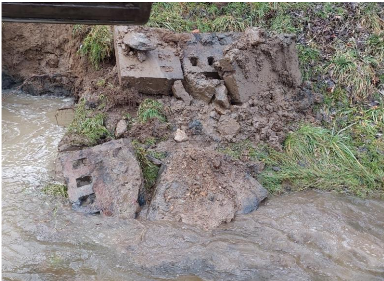
Obr.: Opevnění břehu vegetačními tvárnicemi
